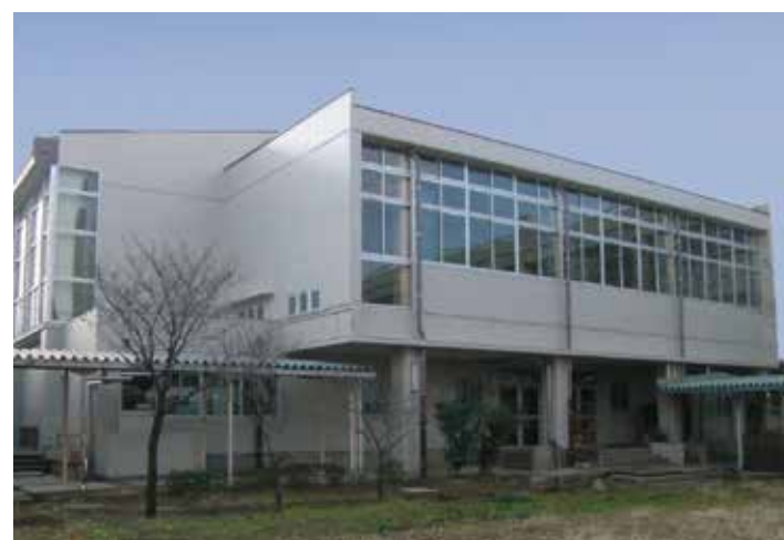
春日部市立 葛飾中学校体育館 耐震補強
