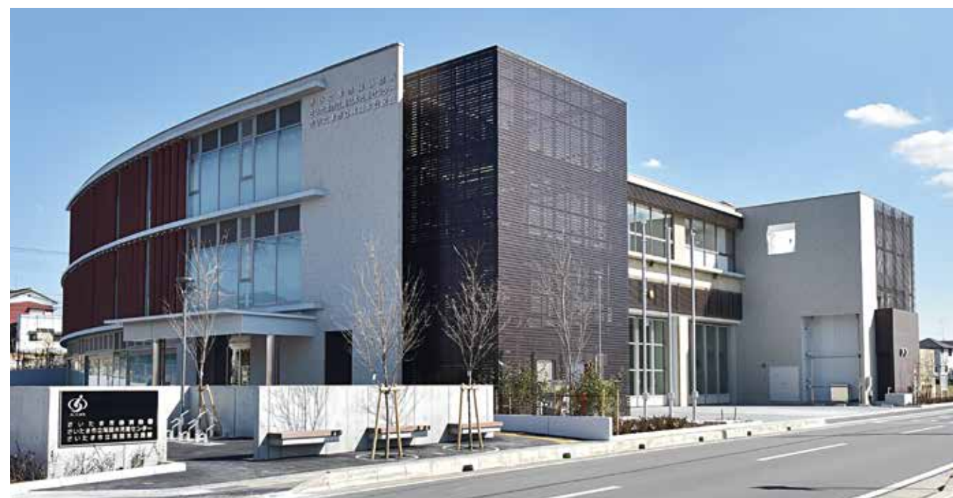
さいたま市 緑消防署等複合施設
