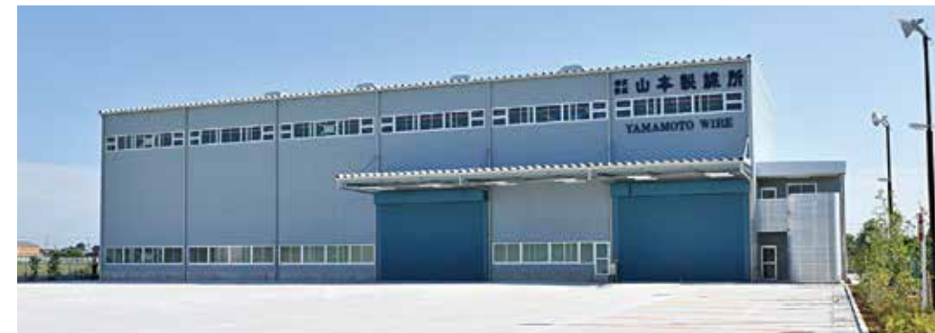
●(株)山本製線所 加須工場
