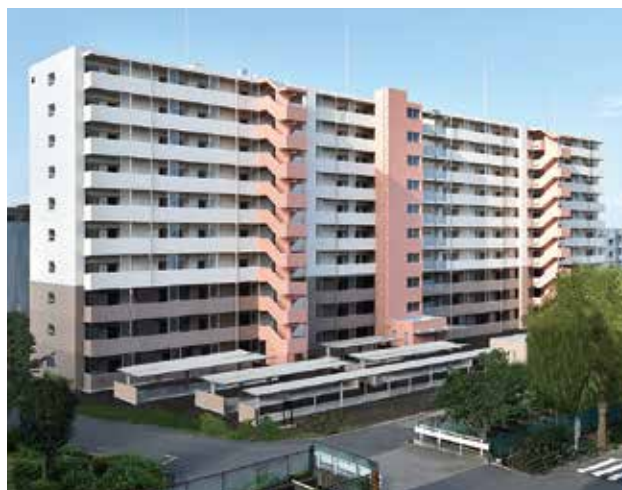
県営大宮東宮下住宅 高層6号棟
