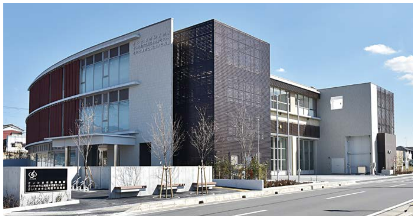
さいたま市 緑消防署等複合施設
