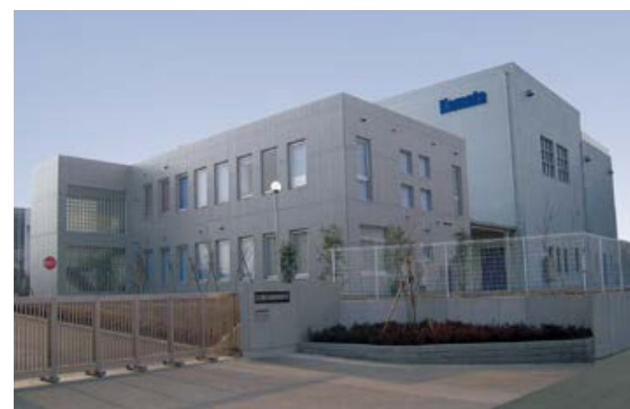
●(株)鎌田機械製作所 日高工場 リニューアル
