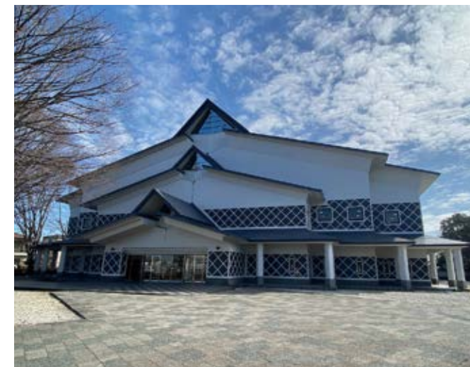
さいたま市 大宮武道館(改修)
