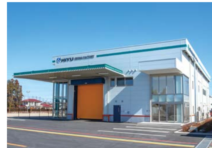
●(株)奥井組 本社F-1区倉庫
