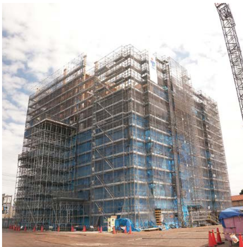
●アキュラホーム本社屋(木造8F)(建設中)
