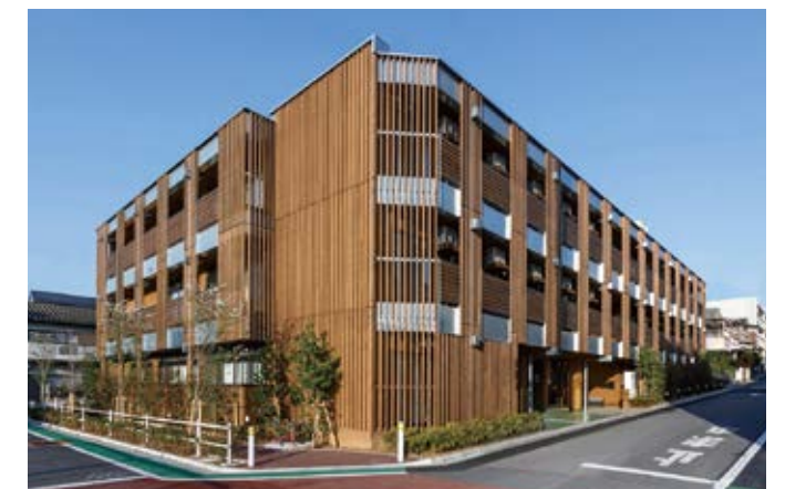
メディカル・ケア・サービス(株) 愛の家板橋小茂根
