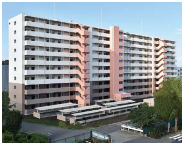
県営大宮東宮下住宅 高層6号棟
