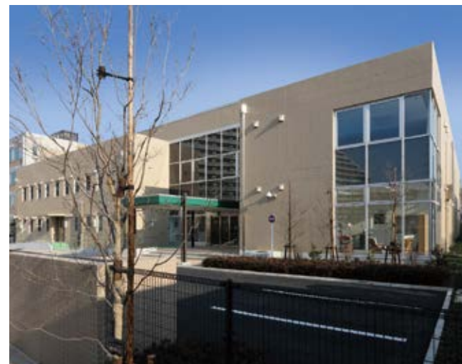
さいたま市立 つばさ小学校体育館改修
